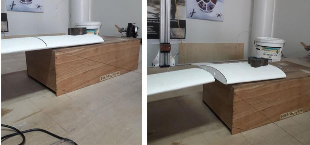
Figure II.10. Découpage de l'aile en deux parties pour le renforcement
