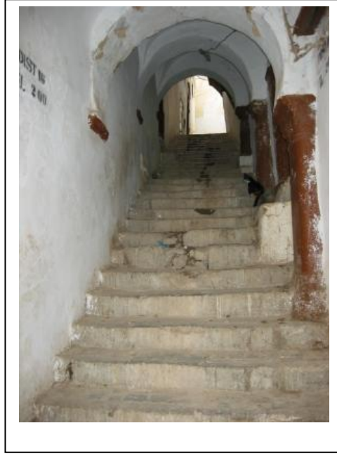
صورة في سلام داخل احد الاحواش تظهر فيها طريقة البناء القديمة بالاقواس الحاملة (من التقاط الطالب )
