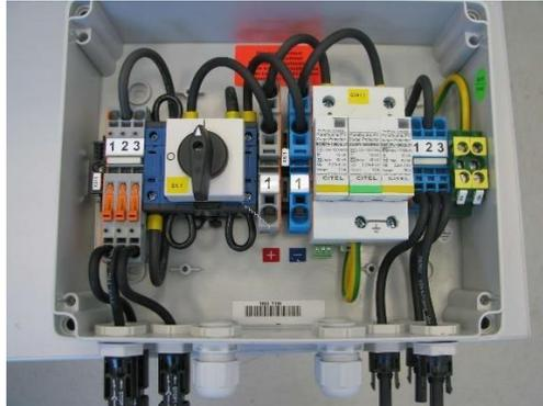
Figure (II.23) : Les boîtiers de raccordements
