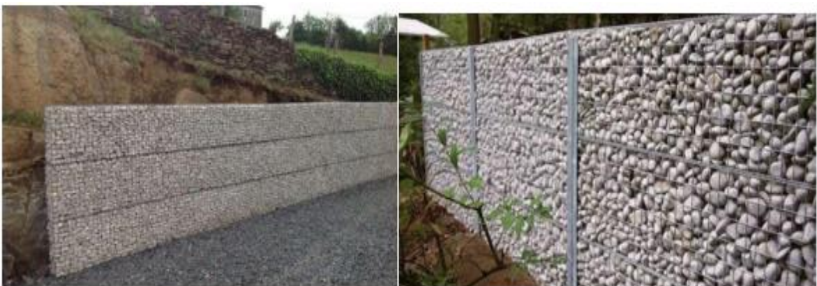
Figure 1.29 : Renforcement par grillage ou treillis métalliques.
