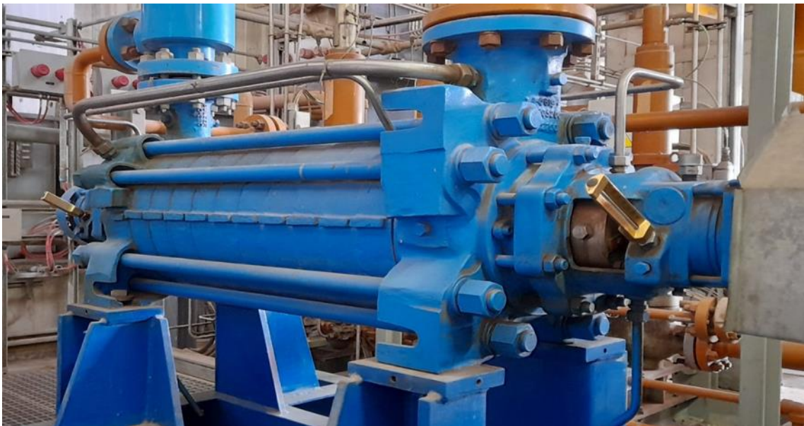
Figure (3. 2): pompe centrifuge HP à 11 étages
