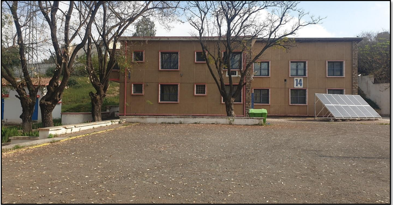
Figure II.10 : Le site d'intervention.
