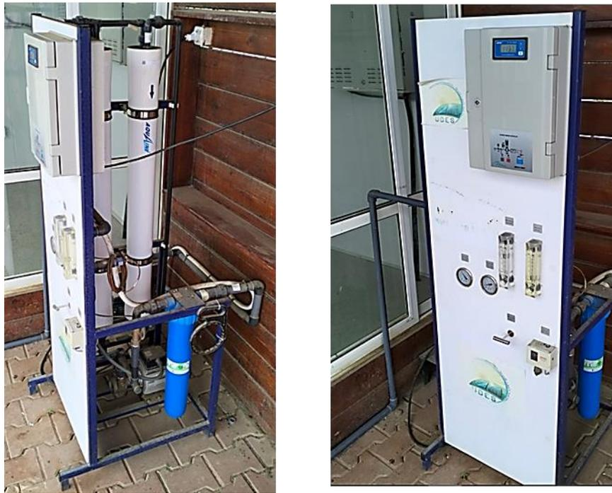
**Figure III.21:** Système d'osmose inverse installé sur la plateforme de l'UDES .
