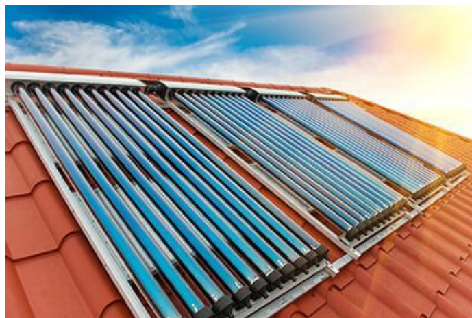
Figure I.17 : Capteurs solaires thermiques sous vide [19]
