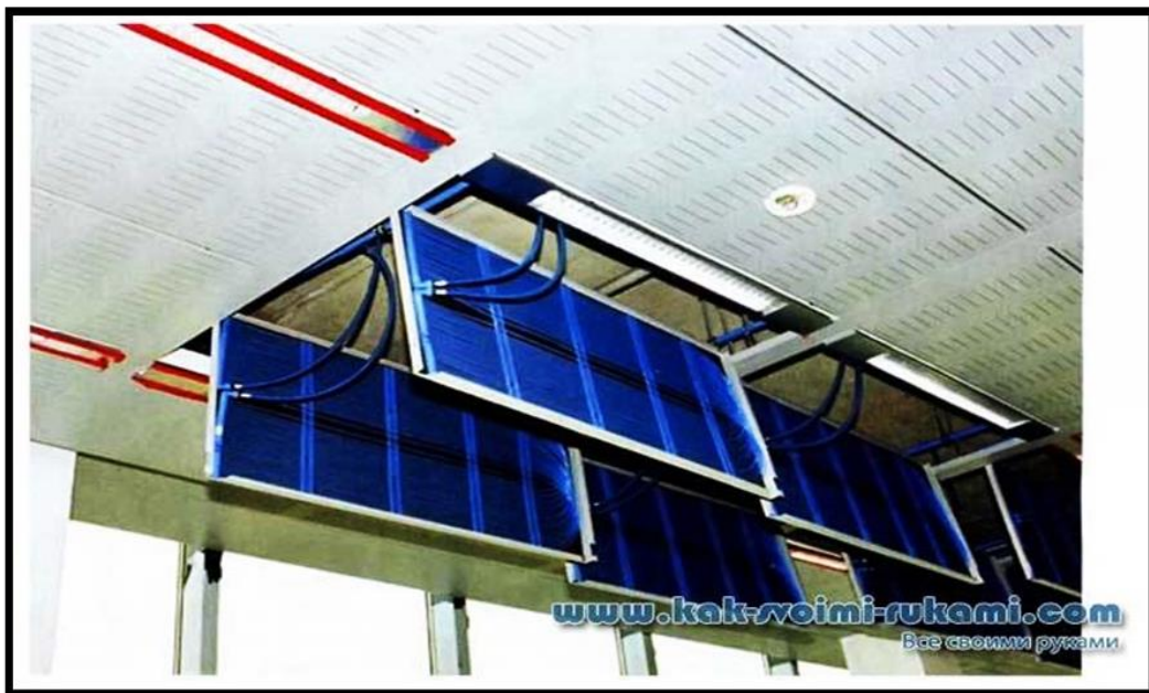
Figure I.13 : Natte capillaire construit d'un faux-plafond [17]
