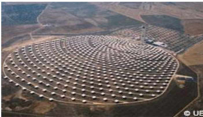
Figure 2.2 : champs d'héliostat orienté Sud[24]
