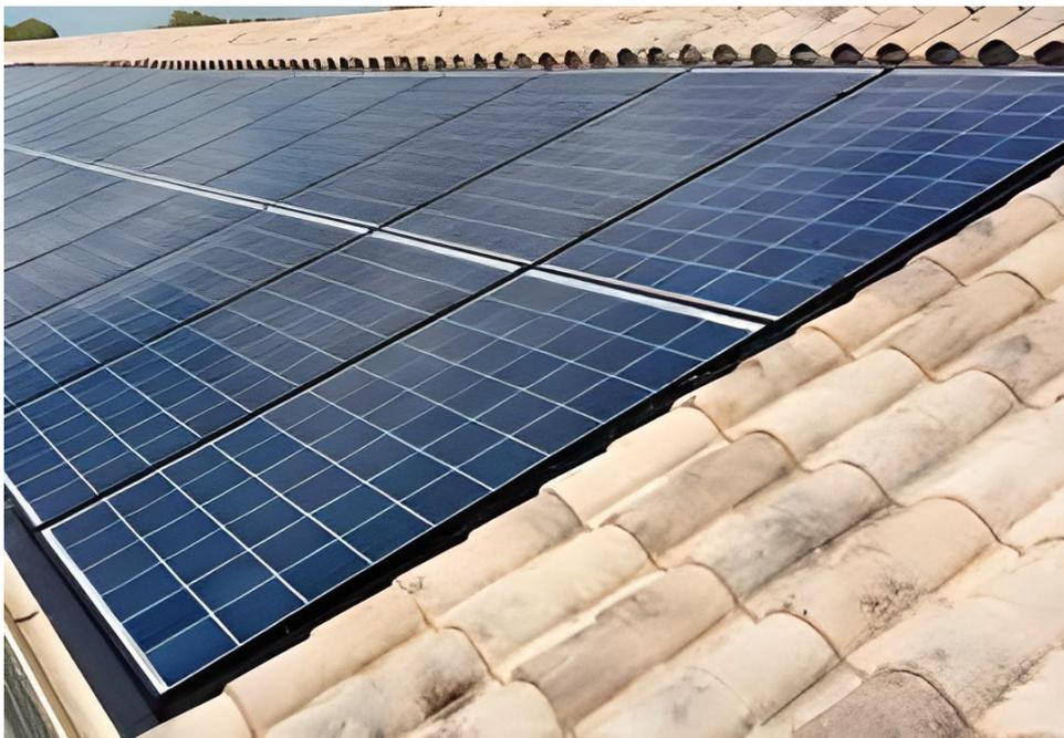
Figure I. 24 : Panneaux photovoltaïques intégrés au bâtiment
