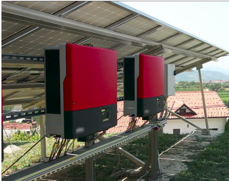
Figure I.9 Onduleur [12]
