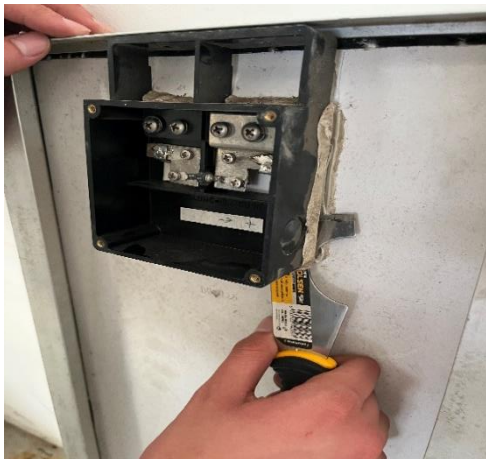
Figure III -3: Démantèlement de la boîte de jonction
