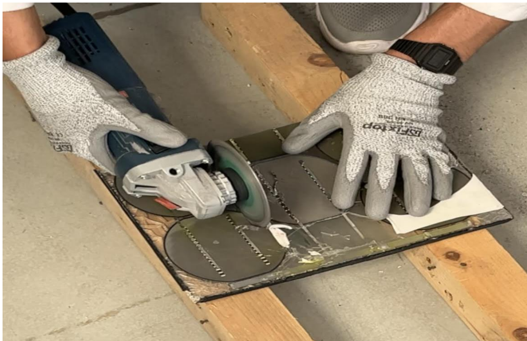
Figure III -11: Opération de découpe du panneau
