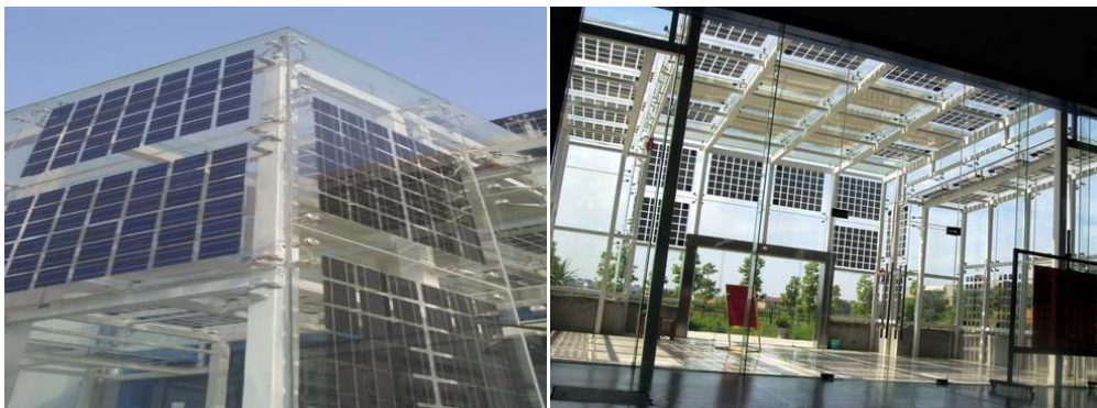
Figure I. 15: Verre photovoltaïque semi-transparent avec double vitrage, verre photovoltaïque semi-transparent triple vitrage. [7]
