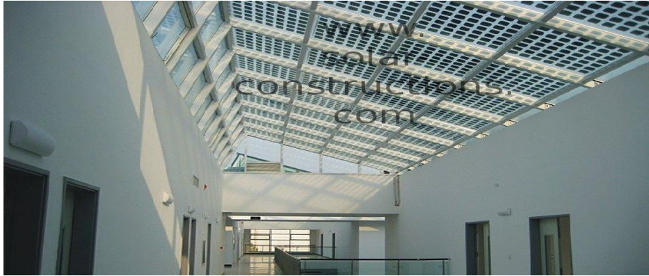
Figure I.14: utilisation des panneaux transparents dans le Toit.[7]
