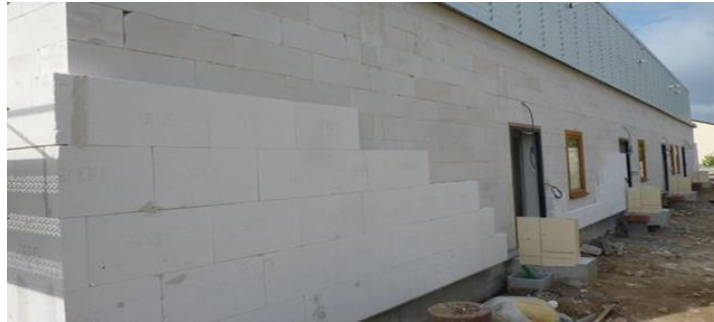
Figure II. 12: Isolation en béton cellulaire.
