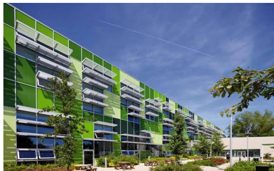
Figure I. 7: Protections solaires dans bâtiment.
