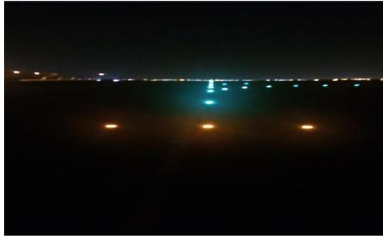
Figure III.19: Balisage de la barre d'arrêt
