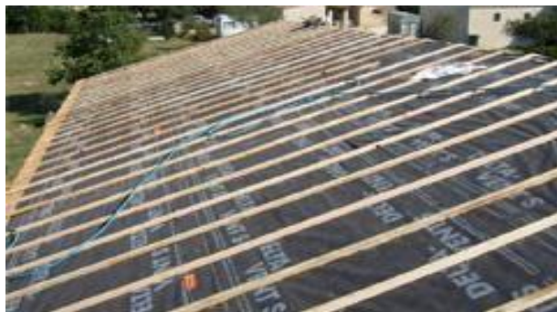
Figure I. 12: Écran souple de sous-toiture constitué d'une feuille plane lisse en polypropylène perméable à la vapeur d'eau et de deux non-tissés en polypropylène. [12]
