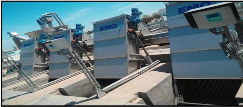
**Figure II.3:** Dégrilleur automatique fin.
