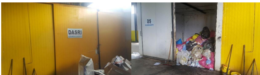
Figure III.7 : Chambre de stockage des DAS de CET de Beni Mered
