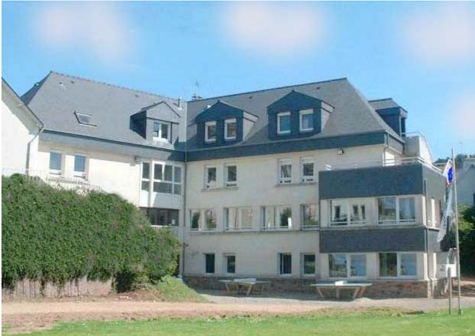
2.13.B : Le bâtiment d'hébergement depuis le parc.
