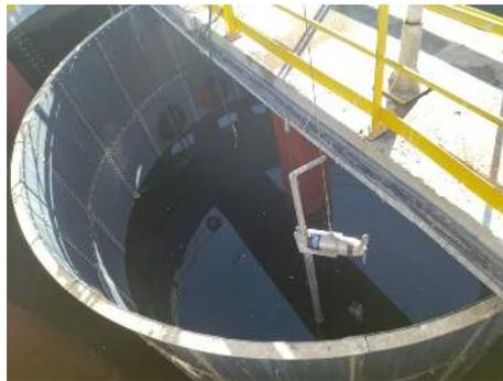
**Figure III-11:** Cuve de dénitrification + agitateur
