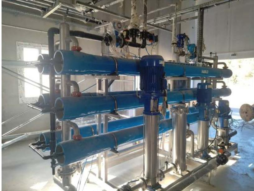
**FigureIII-20** :Système Nanofiltration
