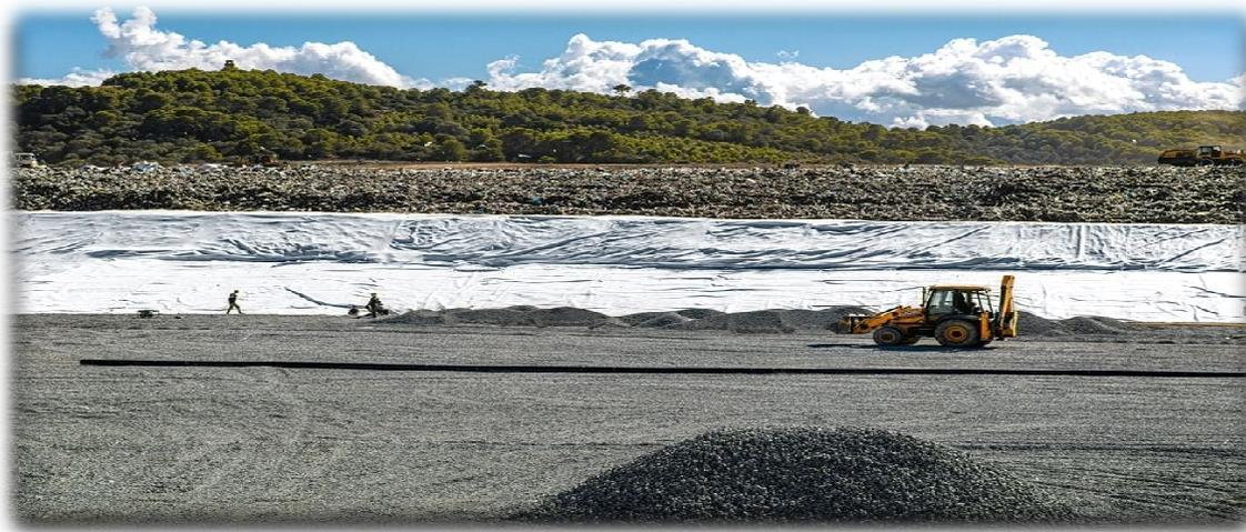
**Figure IV-04:** La pose de la géo membrane en polyéthylène haute densité (PEHD)
