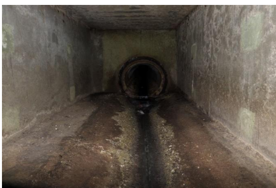
Dépôts entreposés-obstruction de toute la Section du Collecteur Ø800mm
