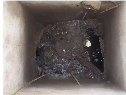
Dépôts entreposés-obstruction de toute la Section du Collecteur Ø800mm
