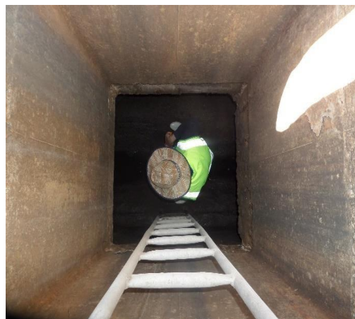
A l'intérieur du Regard de tête de la Section (A)
