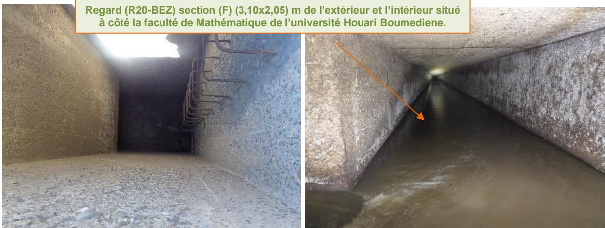
Figure V.19: Travaux de Diagnostic et d'auscultation physique du collecteur Bab Ezzouar mené à l'intérieur de l'ouvrage pour le Regard - pour le tronçon passant par le Boulevard de l'université Houari Boumediene.
