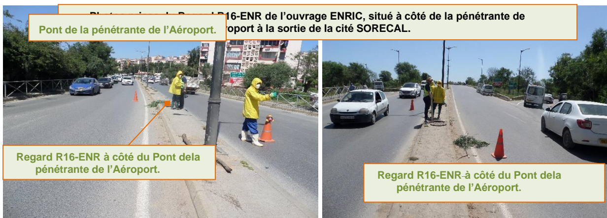
Figure V.10: Diagnostic du collecteur ENRIC pour le tronçon au niveau de la section (C).
