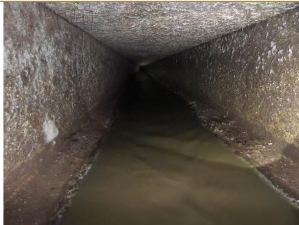
Figure V.21: Travaux de Diagnostic et d'auscultation physique du collecteur Bab Ezzouar mené à l'intérieur de l'ouvrage pour le Regard R24-BEZ, pour le tronçon passant à l'intérieur de l'université Houari Boumediene jusqu'à l'arrivée au point de raccordement avec le collecteur de la cité Smail Yefsah.
