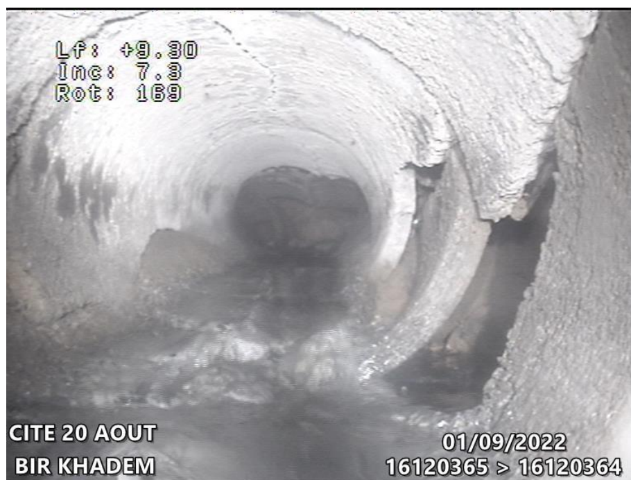
Figure I.7: Trous (paroi manquant).
