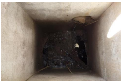
Photos Prises à l'intérieur de Regard du Collecteur Ø800mm desservant l'ouvrage ENRIC juste en Amont de la Section (A).
