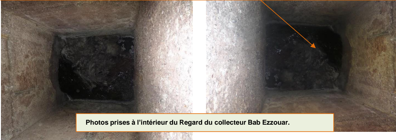
Figure V.18: Travaux de Diagnostic et d'auscultation physique du collecteur Bab Ezzouar mené à l'intérieur de l'ouvrage pour le Regard, pour le tronçon passant par le Boulevard de l'université Houari Boumediene.
