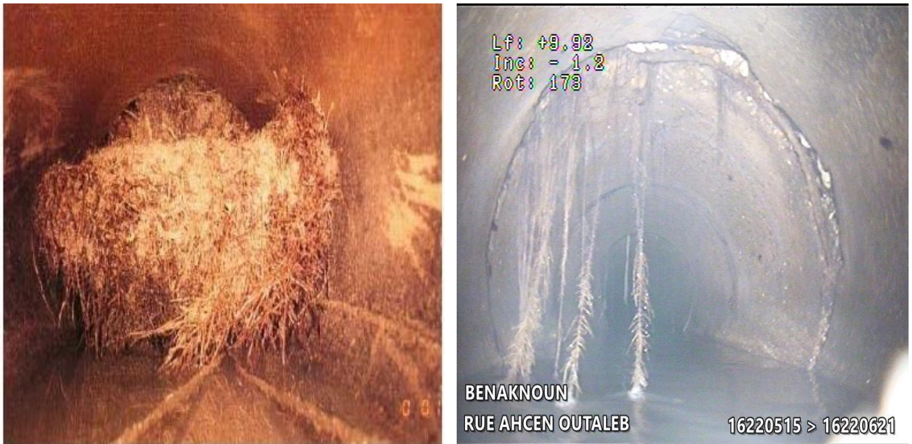
Figure I.4 : Exemple de blocage provoqué par la présence de racines.
