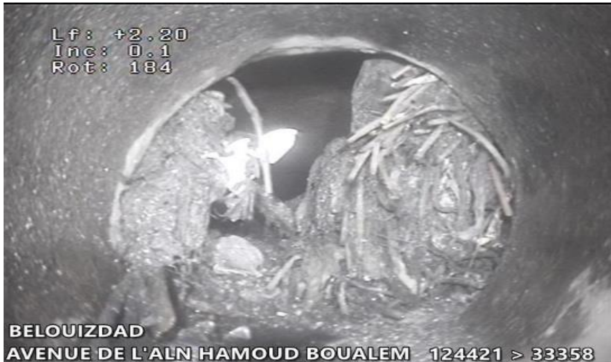
Figure I.3: Exemple d'obstruction
