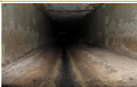
Photos Prises à l'intérieur de l'ouvrage ENRIC au niveau de la Section (A) de dimensions (1,60x1,60) m
