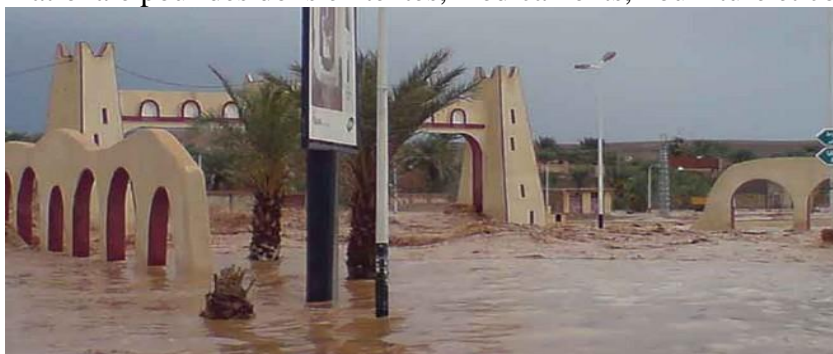
Figure I. 13. inondation de Ghardaïa 1 (Wikipédia)
