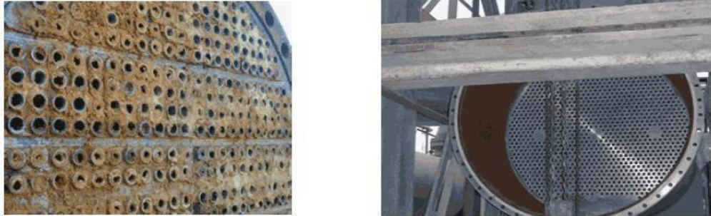
Figure. I 22 : Echangeur propre (à droite) et échangeur sale (à gauche)
