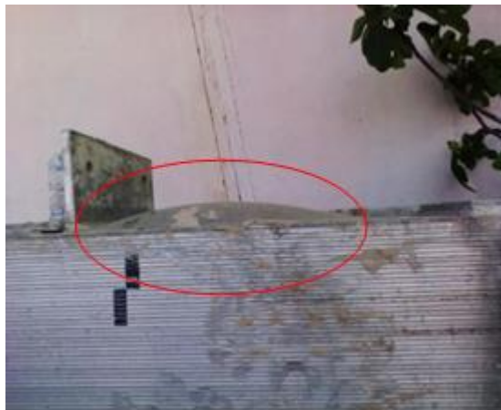
Figure. I .23 : Déformation de la tôle extérieure d'un échangeur de chaleur
