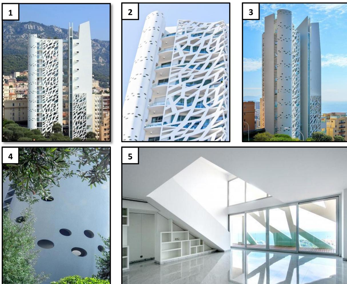
L'image 01 représente la façade Sud, divisée en deux blocs et reliés entre eux par des passerelles. L'image 02 représente le traitement de cette dernière en résille de béton blanc treillissé. L'image 03 illustre la façade sud-ouest contenant le cylindre de la piscine. L'image 04 illustre son traitement avec des percements ovales. L'image 05 représente la grandeur des ouvertures donnant sur la mer.
