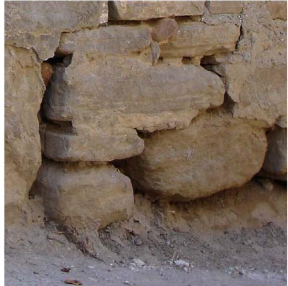
Détail d'érosion de la pierre et du mortier dans un soubassement de mur.
