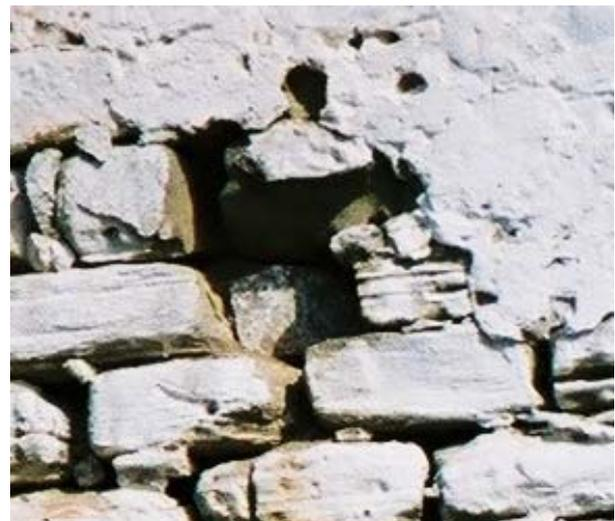
Détail de détachement de pierres dans un soubassement de mur.
