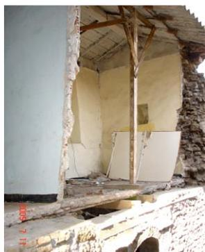
Etalement de des charpentes et reconstruction du mur jusqu'au plancher.
