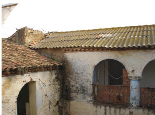
Figure n° 6.2.9.4. Inversion du sens d'écoulement de la partie angulaire sujette aux infiltrations.
