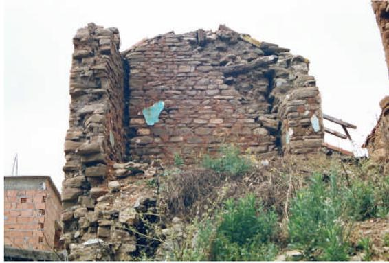
Figure n° 7.2.3 (2) : Ecartement du mur de refend des murs longitudinaux, du à un défaut de harpage.
