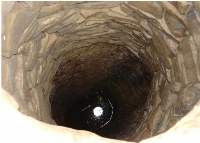
Figure n° 7.1.1.(1) : paroi d'un puits, inférieure à la margelle, reposant sur la strate rocheuse.
