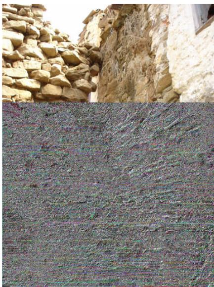
Détail -A - : Vue de l'angle d'une cour montrant deux cellules s'assemblant à joint sec. (Photo: Bougdal Kamel, 2005)
