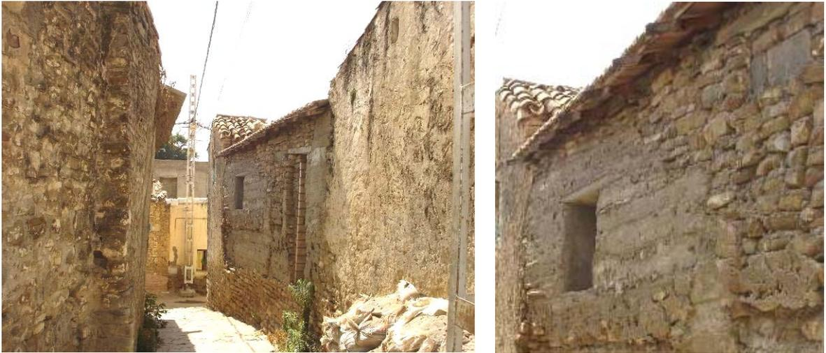
Reconstruction d'un mur sur les substructions de la vieille maison. Ici la pierre est réutilisée en association avec le béton comme matériau de remplissage dans des banches, sans aucun souci de finition. Ceci révèle une réelle perte du savoir-faire traditionnel et l'évidente absence de toute culture constructive.
