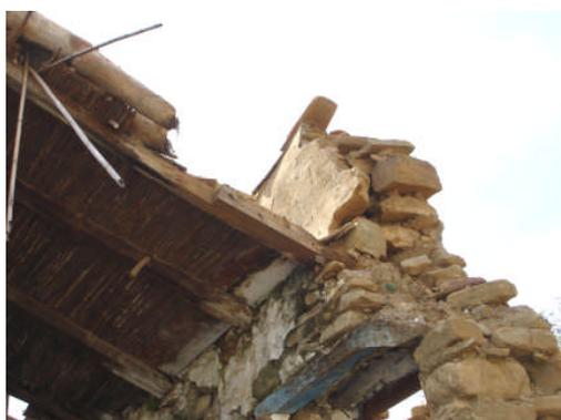
Figure n° 6.2.9.3. Rencontre de toiture et mur pignon donnant lieu à une incohérence dans le drainage des eaux.
