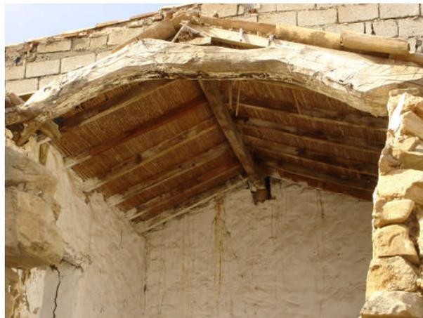
Figure n° 7.2.3 : Liaison entre poutre intermédiaire de toiture et murs latéraux.
