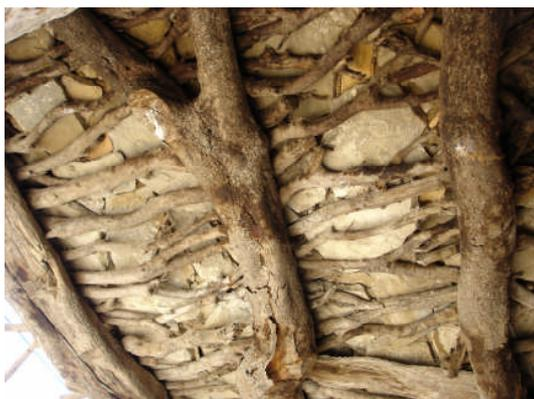
Plafond de plancher primitif en branchage et pierres.
