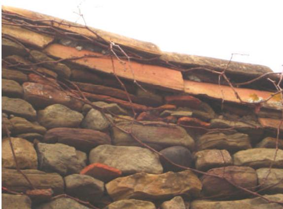
Figure n° 6.2.9.2. Protection de l'arase du mur pignon du ruissellement des eaux.
