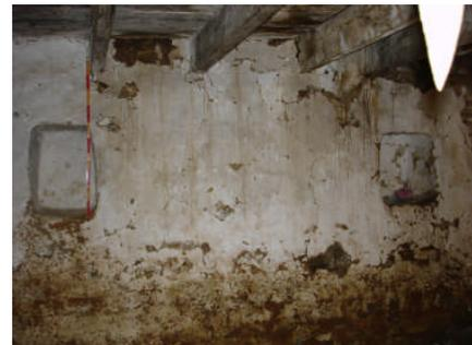
Figure n° 6.4.1 (2): Niches de petites dimensions réservées dans un mur donnant sur l’extérieur.
