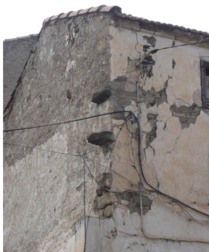
Figure n° 7.2.3 (4): Réserve de pierres de harpage à l'angle d'une maison sur l'alignement de la R.N 24.
