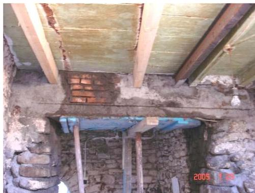
Consolidation du plancher et réfection des linteaux.
