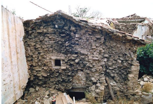
Figure n° 7.2.3(3): Effondrement d'un parement de mur par défaut de boutisses.
