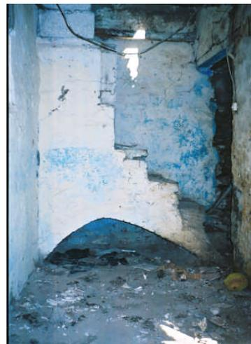
Figure n° 6.3.1.(8): Escalier étriqué aménagé dans le "setwan" dans une tentative de création d'un 2ème niveau.
