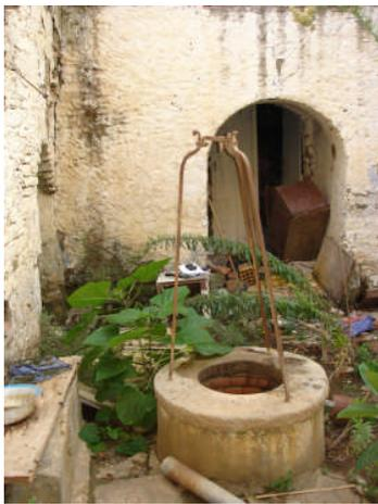
Figure n° 6.3.2 (1): Puits central avec margelle surélevée et système de puisage.
