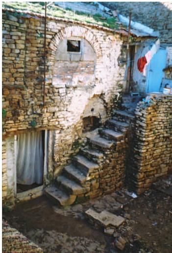
Figure n° 6.3.1.(7): Escalier Primitif sur massif de pierre, accolé à la façade d'un corps de logis.
