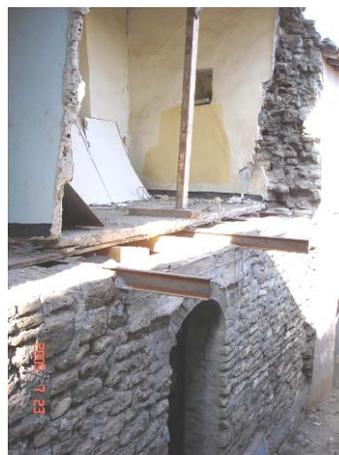
Réservation de poutres en console pour la construction du "qbou".
