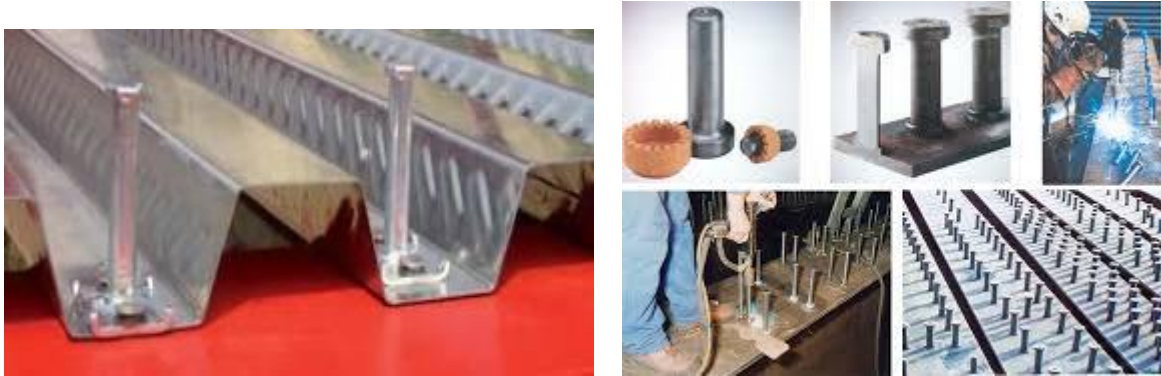
Figure I.5 : Goujon soudé.
