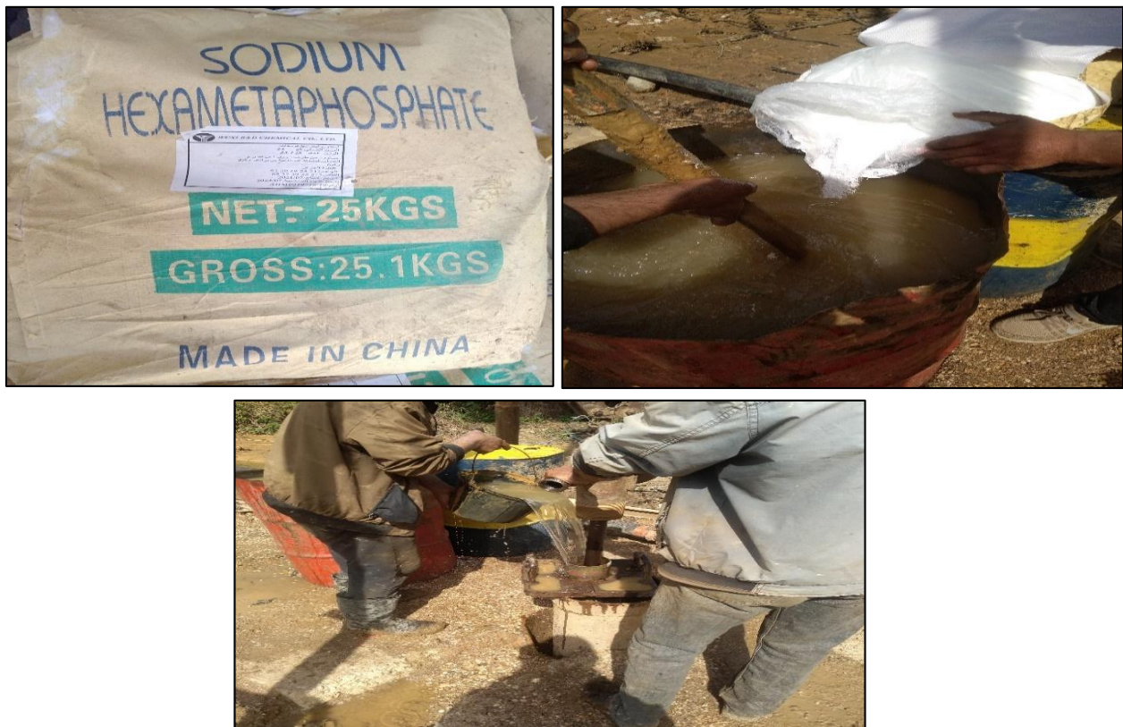
Figure IV-19 : photo préparation et injection de l'hexamétaphosphates
