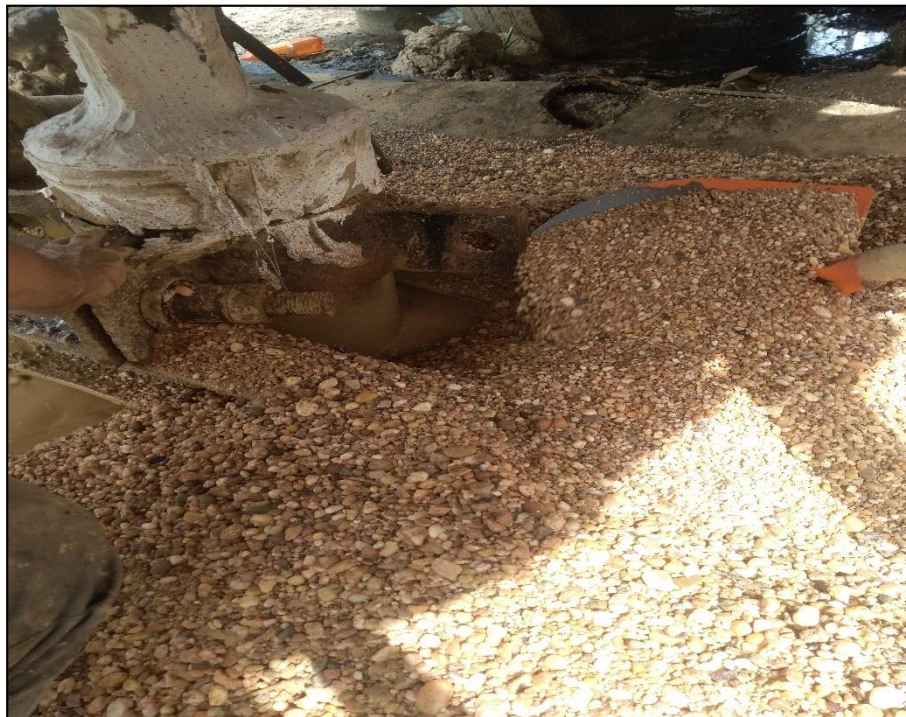
Figure IV-12 : photo de mise en place du massif filtrant
