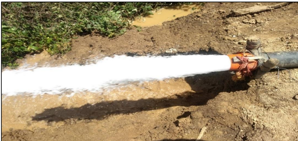
Figure IV-14 : photo d'Opération de développement à l'air lift du captage (vanne ouverte)
