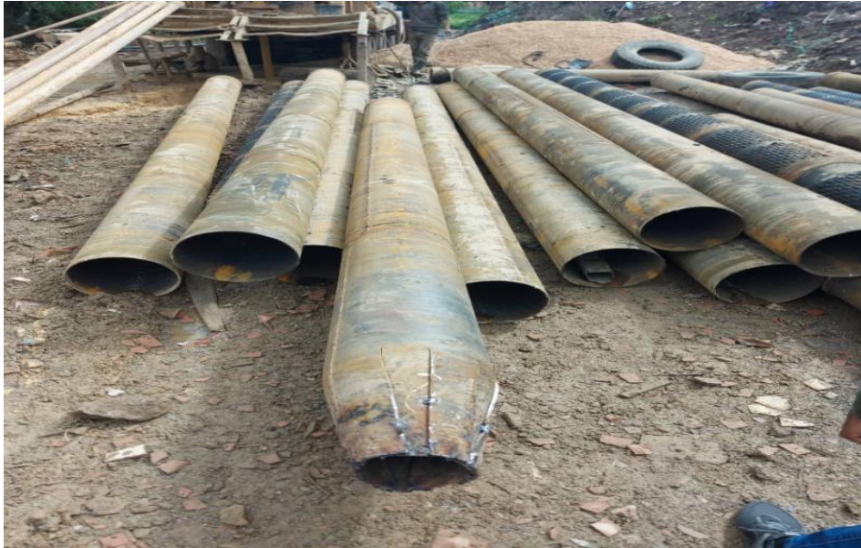
Figure IV-9 : photo de tube décanteur avec sabot
