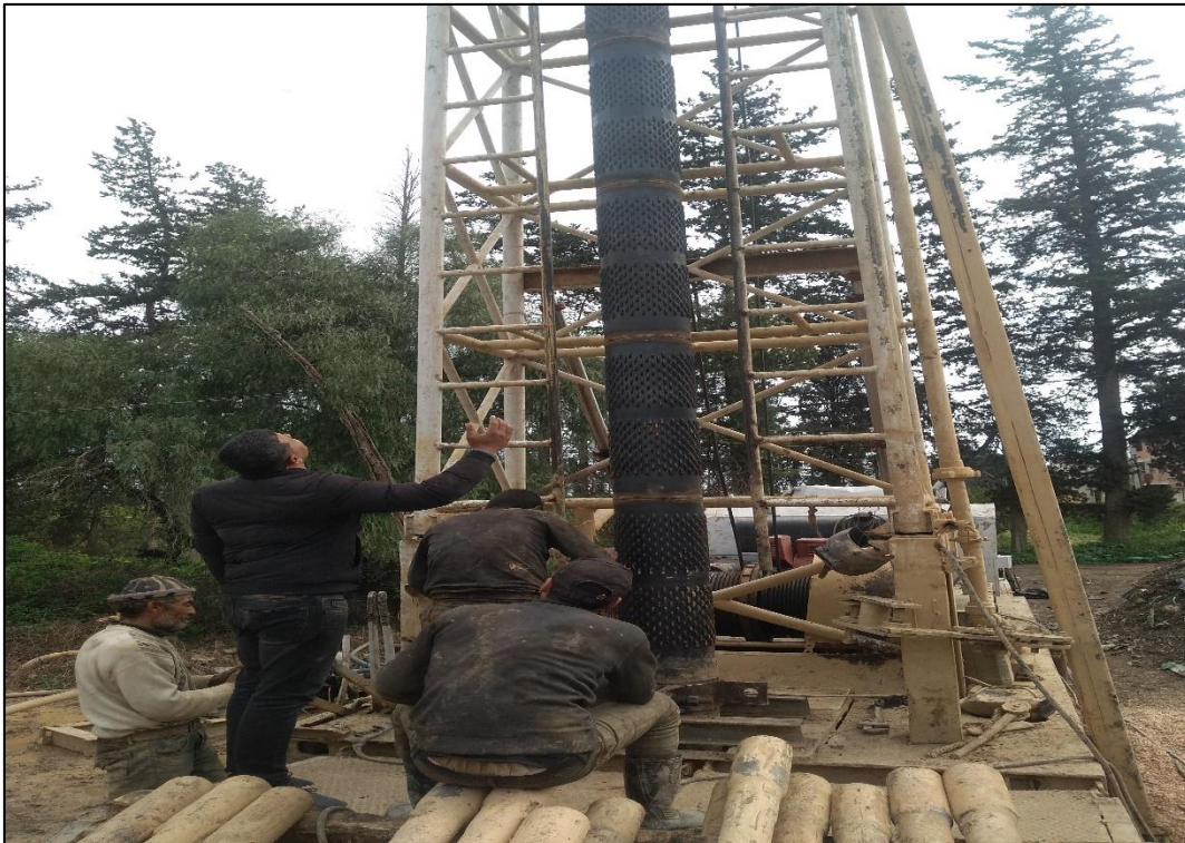
Figure IV-11 : Photo de mise en place du tubage
