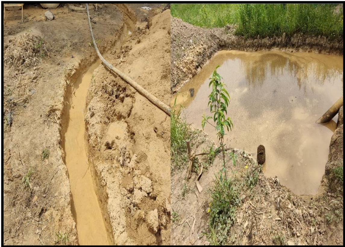
Figure 26 : Bassin de boue
