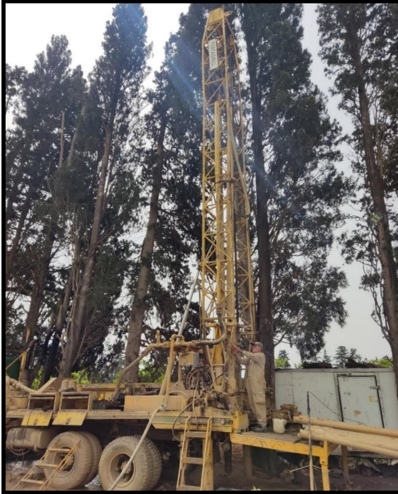
Figure 25 : La machine de forage
