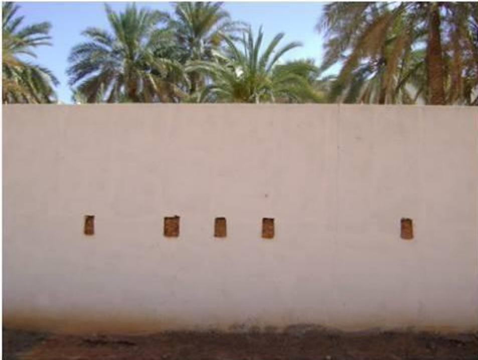
Fig.2.5.les ouvertures du trop plein
