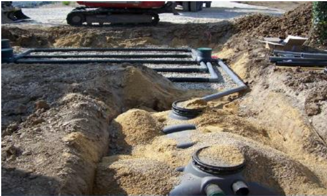
Fig.3.16.installation du système decanteur-digesteur
