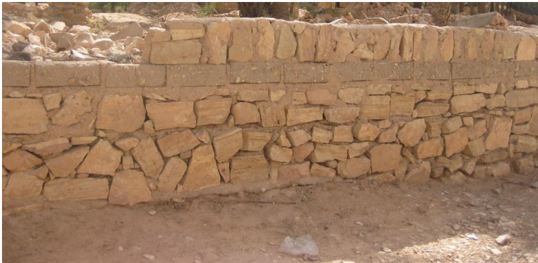
Fig.3.12. reconstruction d'une diguette
