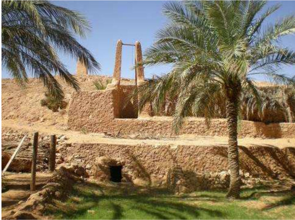
Fig.2.9.photo d'un puits de recharge
