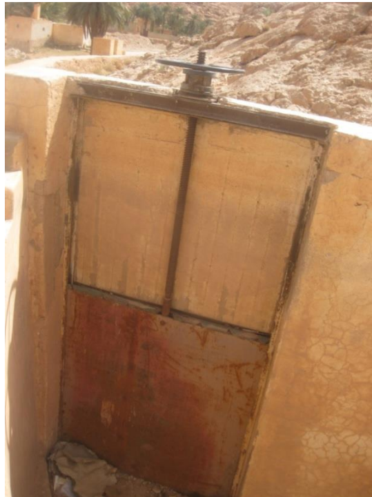
Fig.2.2. une vanne coulissante du barrage Ahbess Ajdid (coté Est)
