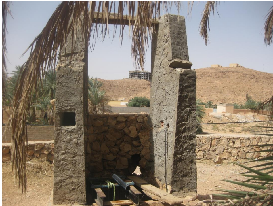
Fig.3.11. puits traditionnel restauré avec des matériaux locaux
