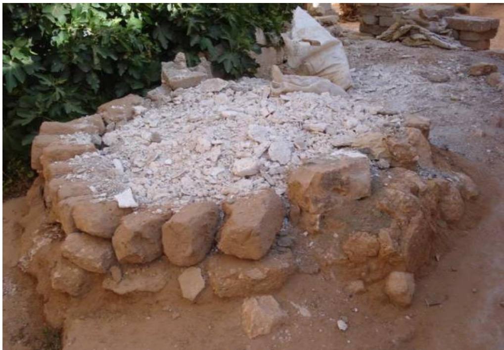
Fig.3.5.un puits traditionnel remblayé
