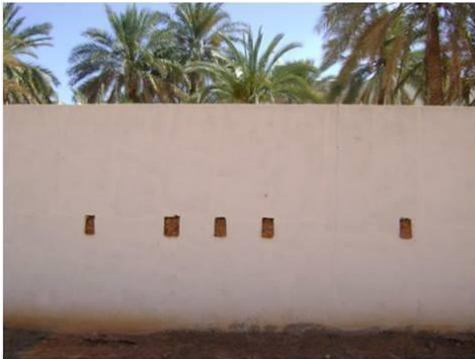
Fig.2.5.les ouvertures du trop plein
