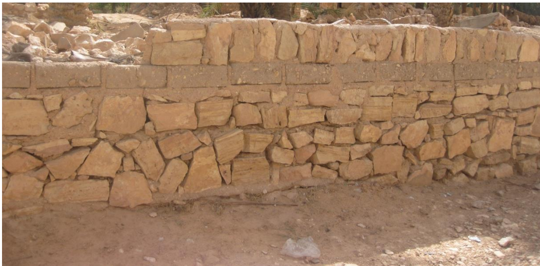
Fig.3.12. reconstruction d'une diguette
