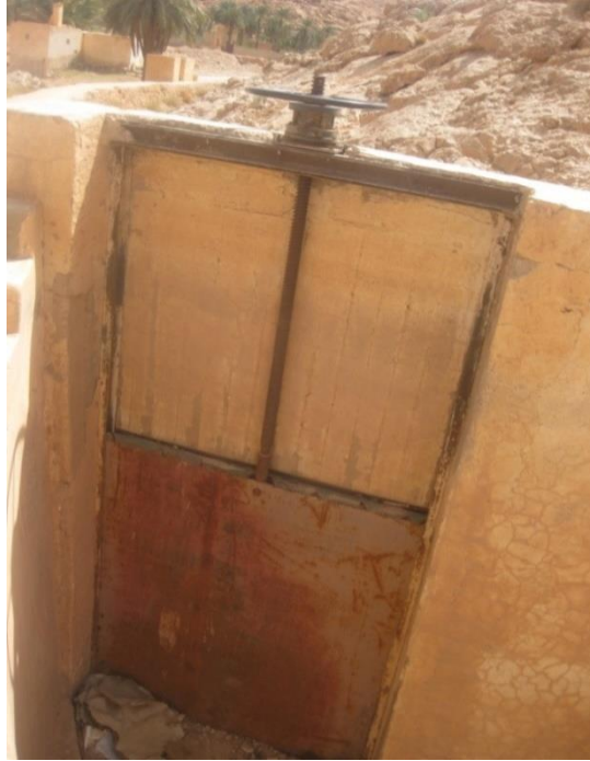
Fig.2.2. une vanne coulissante du barrage Ahbess Ajdid (coté Est)
