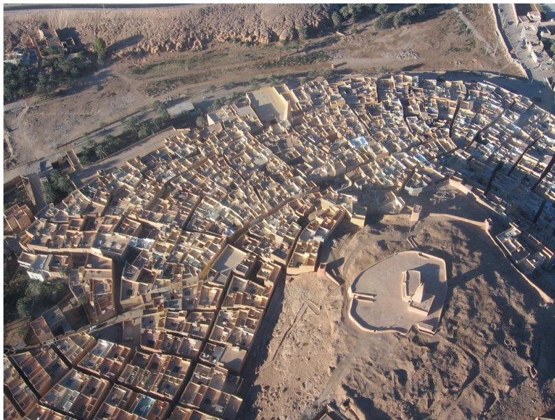
Fig.1.1. Une vue aérienne du Ksar de Bounoura (Google Earth)
