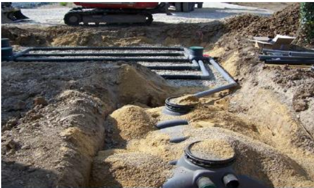
Fig.3.16.installation du système decanteur-digesteur
