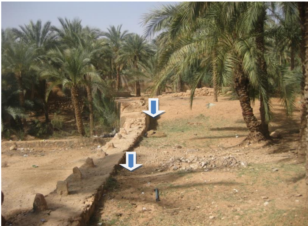
Fig.3.4.une diguette envasée
