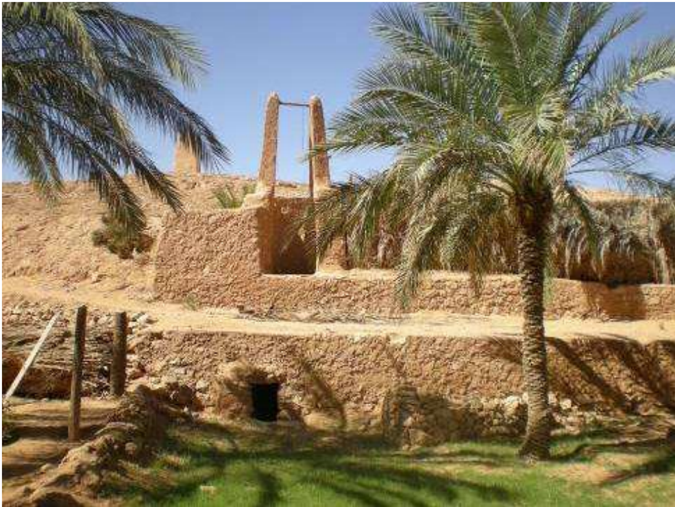
Fig.2.9.photo d'un puits de recharge
