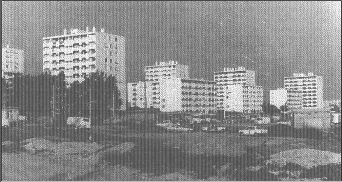
Figure 1.9 : Opération de logement réalisée à l'aide de coffrage outil.
