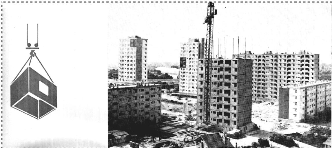
Figure 1.7 : Préfabrication lourde. EPINAY-SUR-SEINE : Architectes : MM. Aillaud et Vedrès.
