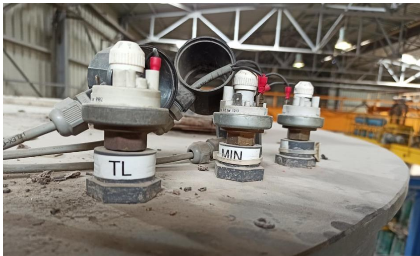
Figure 13 Capteur de niveau par ultrasons
