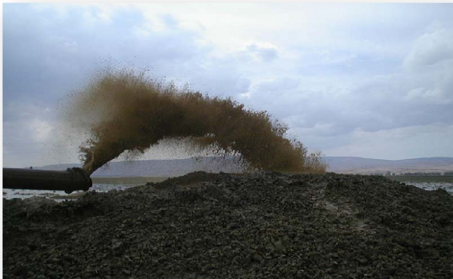
Photo III. 4: Zone de stockage des sédiments. Rejet en cours par drague suceuse (Barrage de Fergoug). (SEMCHA A., 2006).
