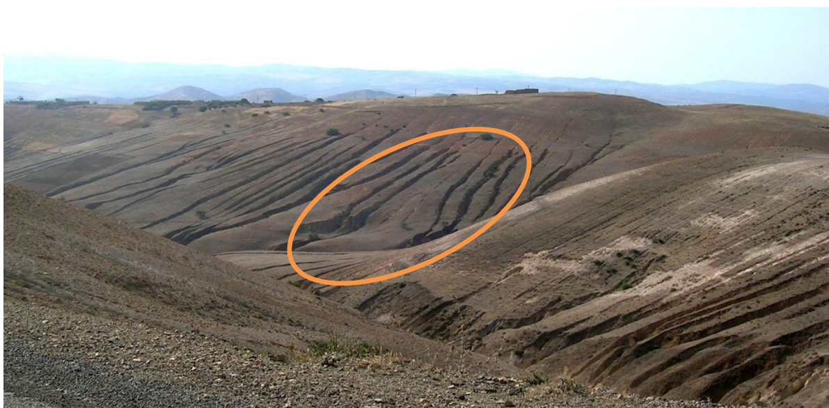
Photo I. 6 Perte des terres arables par l'érosion hydrique en Algérie, Zemmoura (Relizane). (ANRH).
