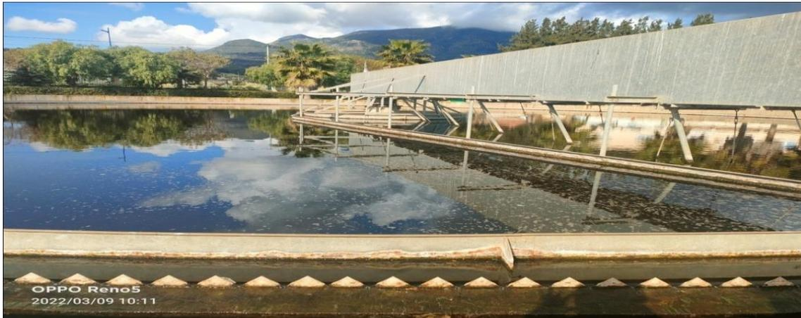
**Figure1.3** : Décanteur
