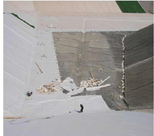
Photo 13 : Pose d'une couche de Géotextile
