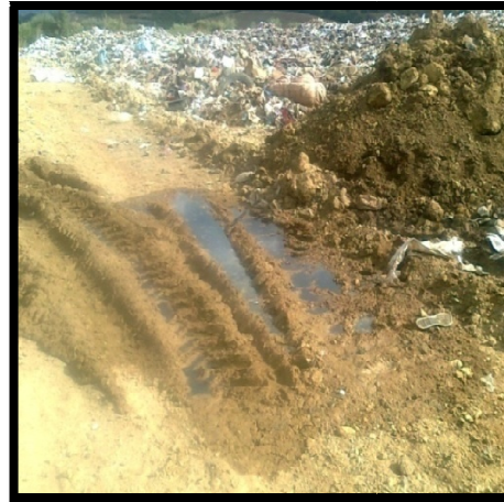
Photo 24: Fuites des digues
