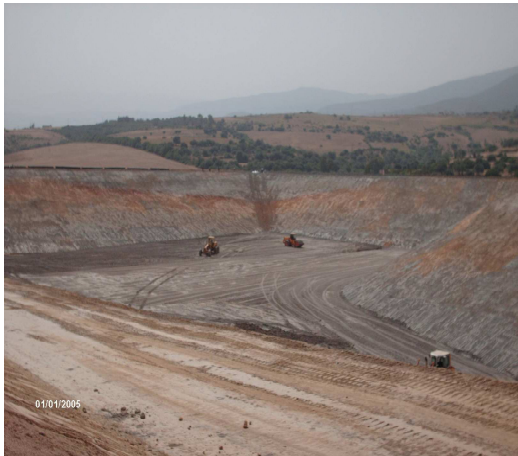
Photo 10 : préparation du fond du casier
