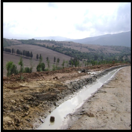
Photo 14 : caniveau de collecte des eaux de ruissellement
