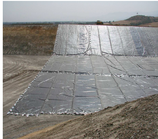
Photo 11 : Pose de la géomembrane dans le casier
