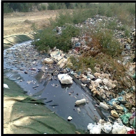
Photo 23 : Accumulation des lixiviats dans le casier
