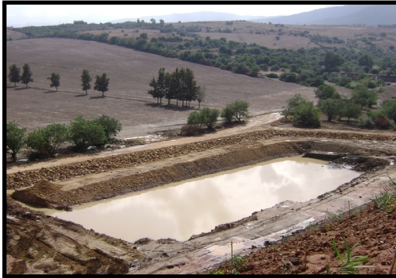
Photo 16 : Bassin de stockage de lixiviat
