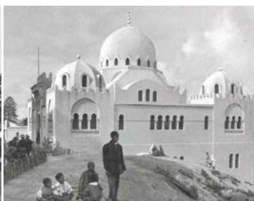
Fig. 77 [Appendice- Part. II]: A gauche : Paul Guion, Paul Régnier, immeuble de la société Standard Oil, boulevard Victor Hugo, v. 1930.
