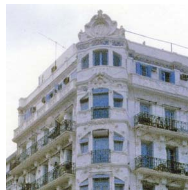
Fig. 38 [Chap. I- Sect. II]: Vue sur l'immeuble situé au coin du boulevard Khemisti et la rue El Khettabi.
