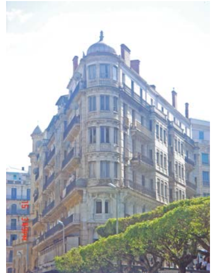
Fig. 26 [Chap. I- Sect. II]: Solution architecturale vis-à-vis de la forme triangulaire de l'îlot.
