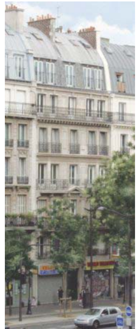
Fig. 1 [Chap. I- Sect. I]: Façade d'un immeuble de rapport du boulevard de Magenta, Paris.
