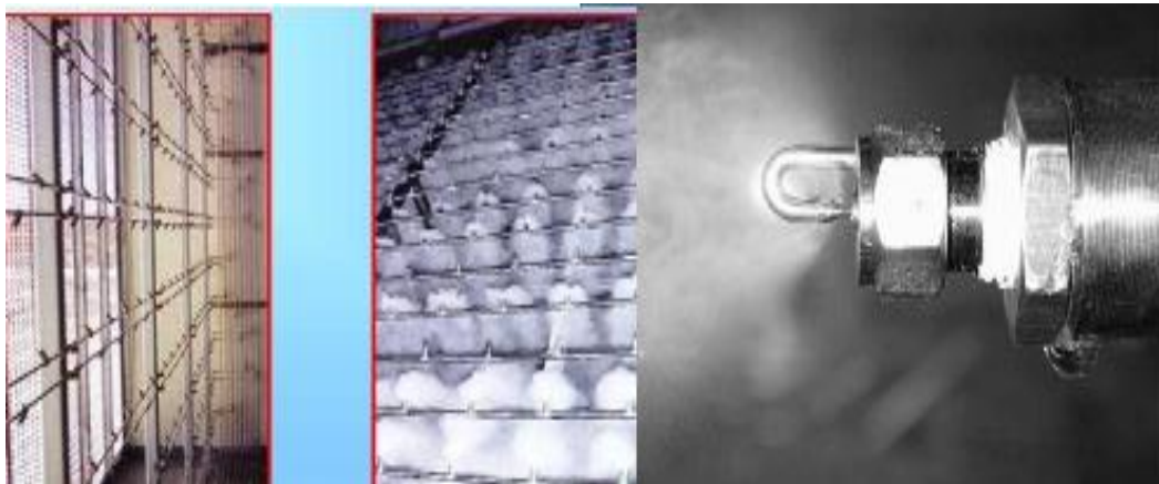
Figure I. 8: Refroidissement par atomisation ou pulvérisation d'eau
