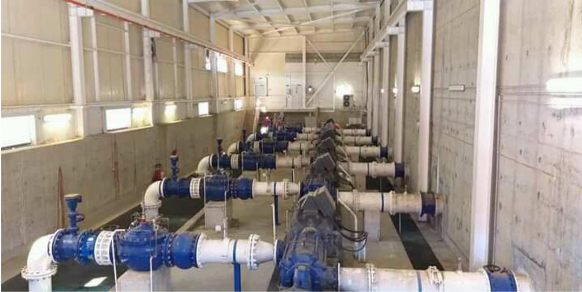
**Figure II.17 :** Station de pompage d'eau traitée.
