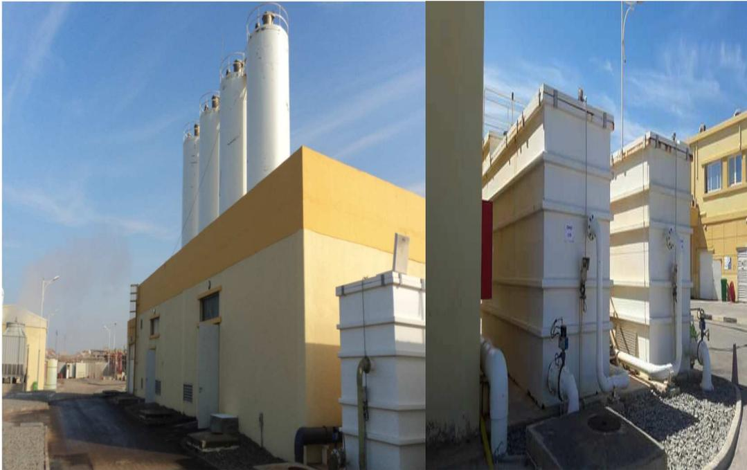
**Figure II.15** : Silos de la chaux
