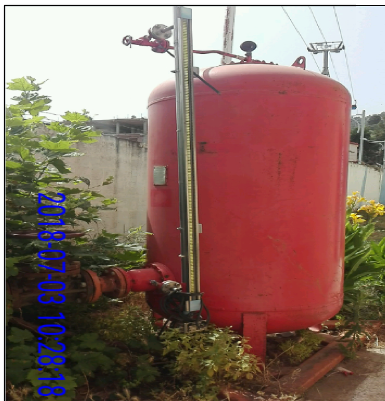
Figure (III.1) : Anti bélier de 1500 litres.
