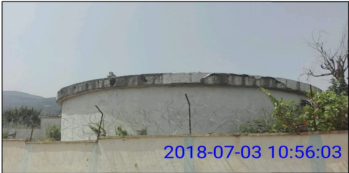
Figure (III.4) : Vue extérieur de réservoir semi enterré RV1000 m 3 .
