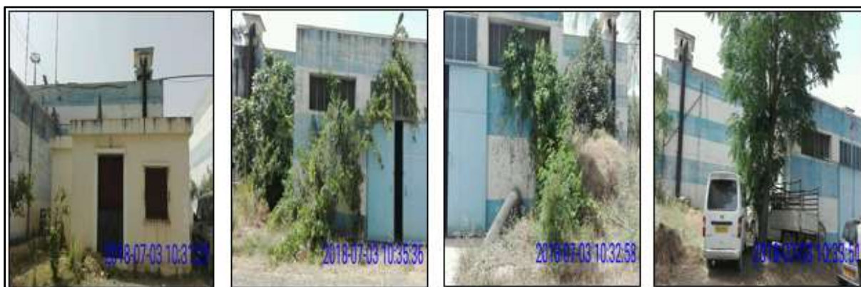
Figure (III.2) : Photo de la vue extérieure de réservoir 4×5000 m 3 .
