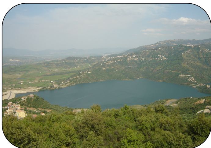
Photo n°1 : Vue d'haut du barrage (ADE, TIZI OUZOU)
