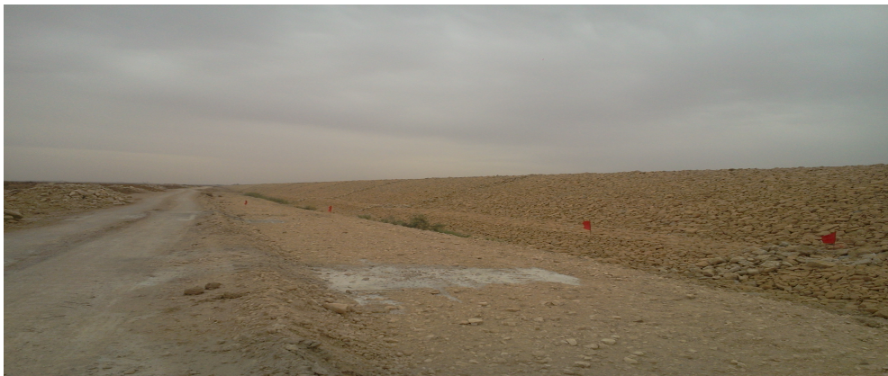
Fig 2.20 Digue sud du barrage de Boughzoul (Nouvelle après construction),(Nasroun T,2012)
