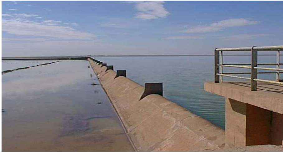
Fig 2.19 Digue sud du barrage de Boughzoul(ancienne)(ANBT 2005)
