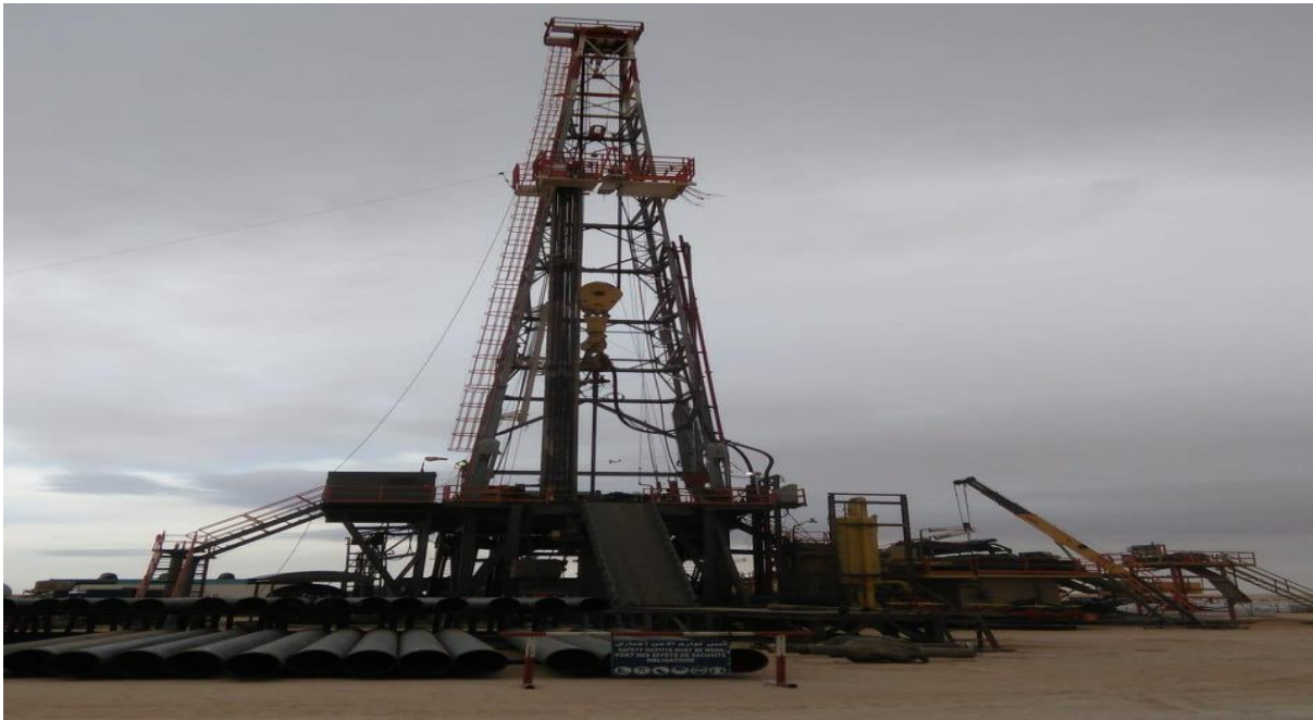
Figure 01: La plateforme du forage OMPFA-9.
