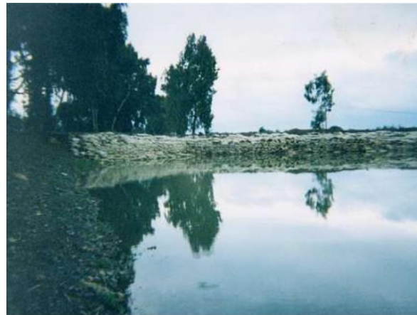
Figure 55: Vue amont de la retenue en BIG-BAG
