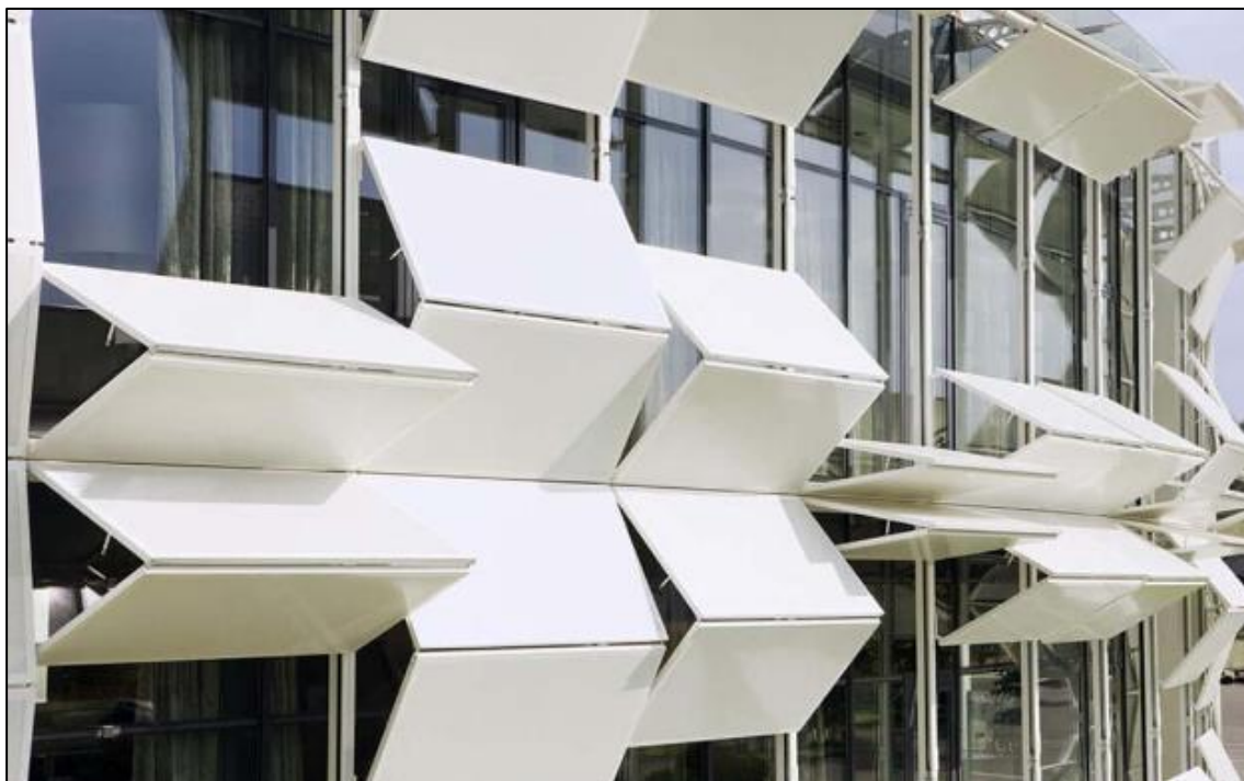
Figure 15 : exemple de dispositifs rabattables de façade intelligente
