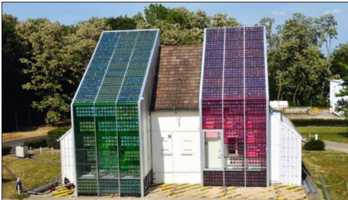
Figure 14 : Façade productrice d'énergie dans un bâtiment résidentiel.
