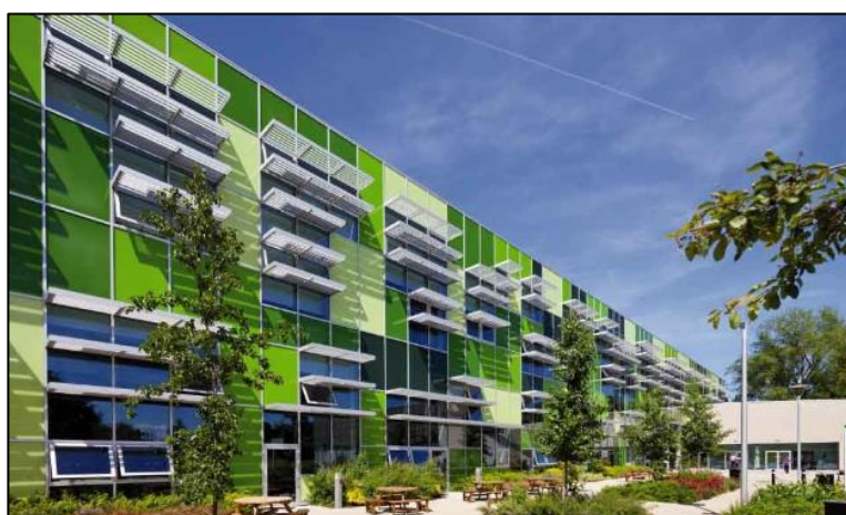
Figure 11 : La protection solaire extérieure par lames brise-soleil-horizontaux. Esso: 2018
