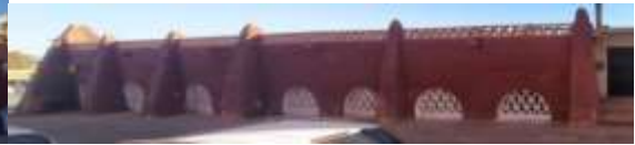
Fig. 16 : Vue sur la façade secondaire
