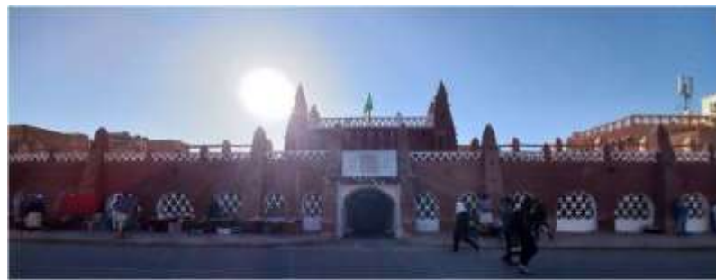
Fig. 58 : façade principale de Capter
