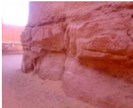
Fig.31 : fondation d'un bâti dans l'Agham Amzegar / Source : les auteures
