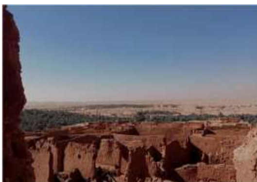
Fig. 06 : vue sur l'oasis de ksar Akhnafo à Timimoun / Source : Auteurs
