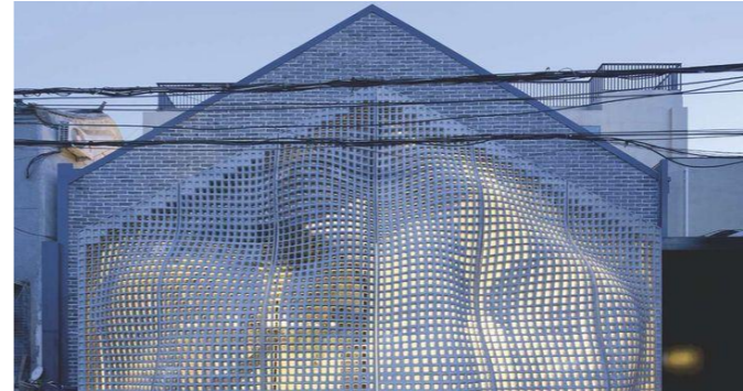
Figure 151 :Les hutongs de Pékin / source : https://courbes-de-beton-fibre-moule.64158%3Ffbclid% .
