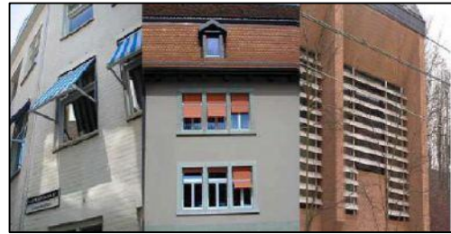
Figure 23 :protection solaire extérieur mobile /source : guide pratique pour la construction et la rénovation durable de petits bâtiments.
