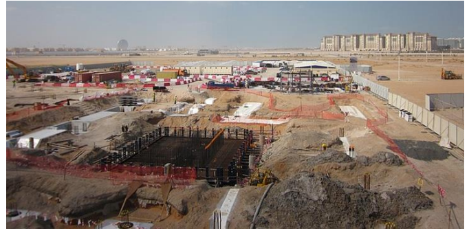
Figure25 : les travaux du chantier. Source : Google earth.
