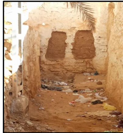
Figure 197 : Les ouvertures aux pieds des murs de clôture. Source : Auteur
