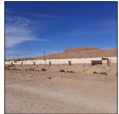
Figure 206 : 150 Chalets individuels. Source : photos prises par l'auteur.
