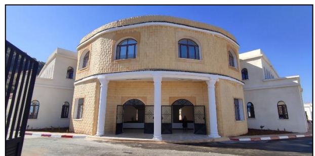
Figure 50 : vue sur accueil. Source : photo prise par l'auteur.
