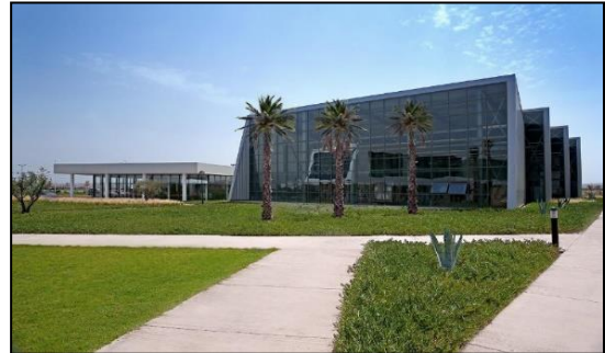
Figure 41 : vue sur les ateliers. Source : ifmeree.ac.
