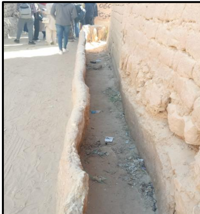
Figure 196 : seguia de distribution d'eau Source : Auteur
