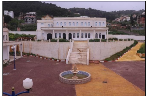
Figure 52 : vue sur les salles de cour. Source : photo prise par l'auteur.
