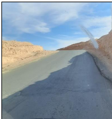
Figure 200 : accès secondaire. Source : photos prises par l'auteur.
