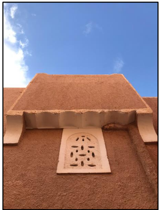
Figure 193 : Photo de revêtement de mortier de chaux avec le régime de dattes sur la façade de la maison de Tafilalt
