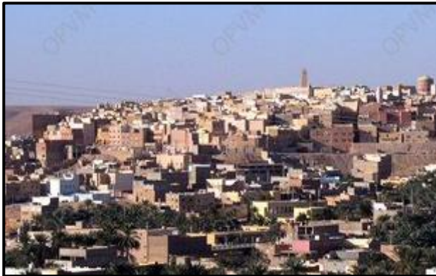
Figure 64 : ksar El Atteuf Source : OPVM
