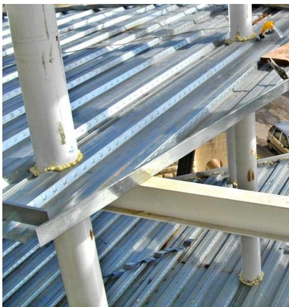
Figure 96: Poteau en section creuse circulaire
