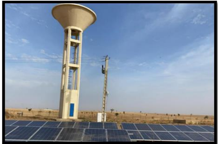
Figure (I.17) : Pompage solaire [20].
