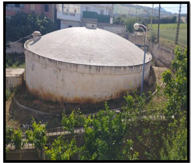
Figure (IV.1) : Château d'eau à Sidi Rached Tipaza.
