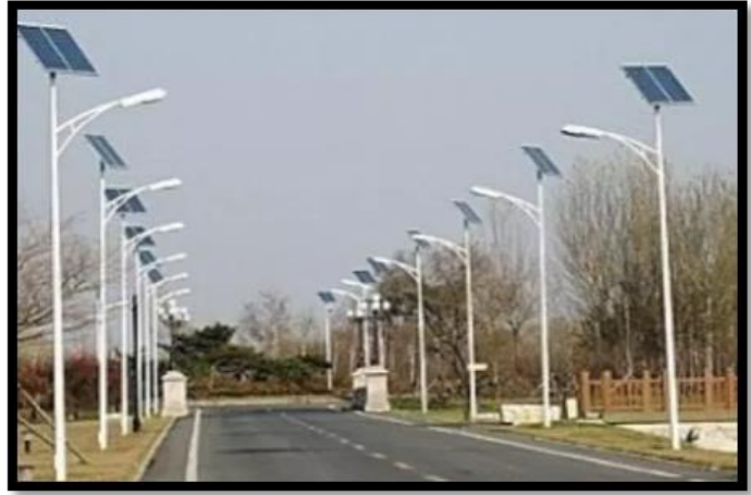
Figure (I.16) : L'éclairage public solaire [18].
