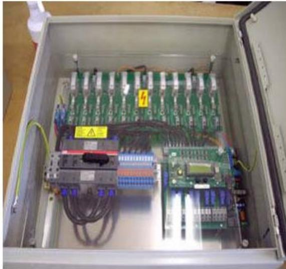
**Figure I.11:**Coffret de raccordement avec coupe-circuit DC, fusibles et surveillance de chaîne.
